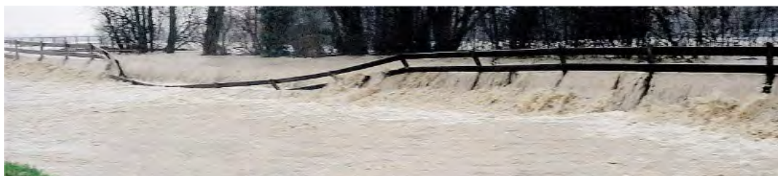
Figura 59 - Sormonto della strada Canaletto in prossimità della rotta.
