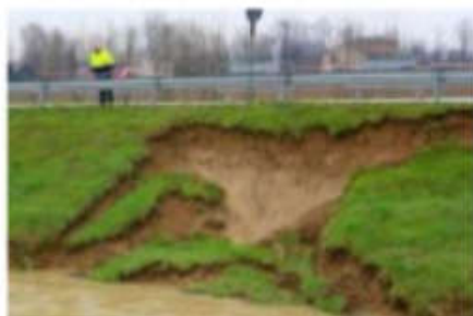
Instabilità del paramento interno
