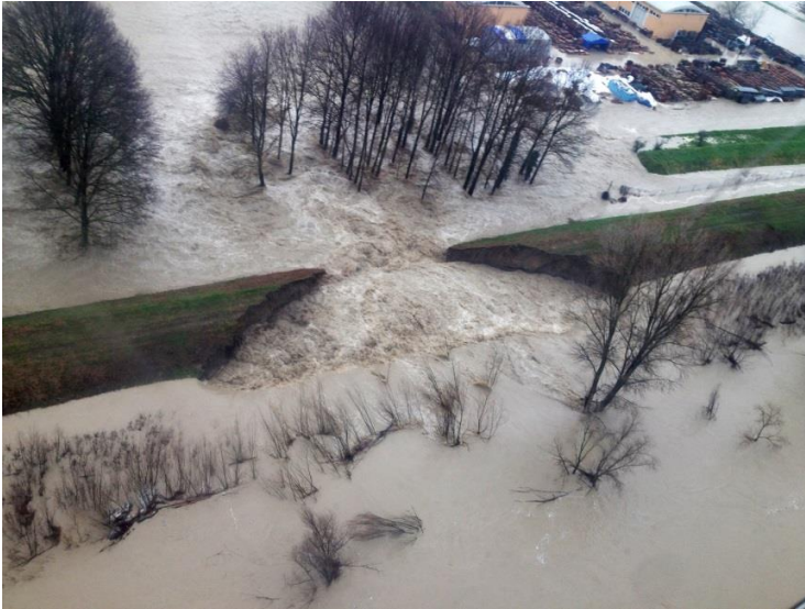
Secchia, 19 gennaio 2014 (sifonamento per la presenza di tane di animali)
